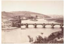
Puente de Behobia - Irun
